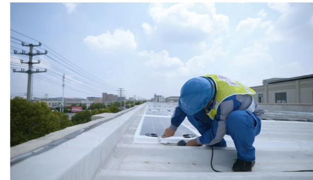
TPO 热风焊接工艺
